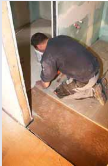
Hier entsteht eine Dusche für die Tagungsräume
